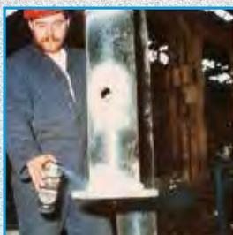
Outre les applications précitées du W73/008, le spécial clair est utilisé de préférence pour réparer des zingages endommagés dans le ton harmonisé.
